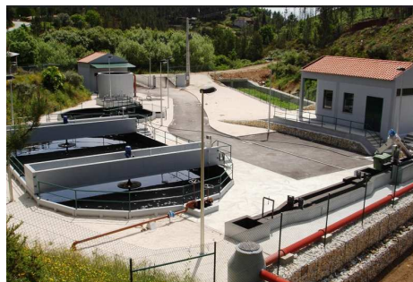
Figura 46. ETAR Figueiró dos Vinhos
