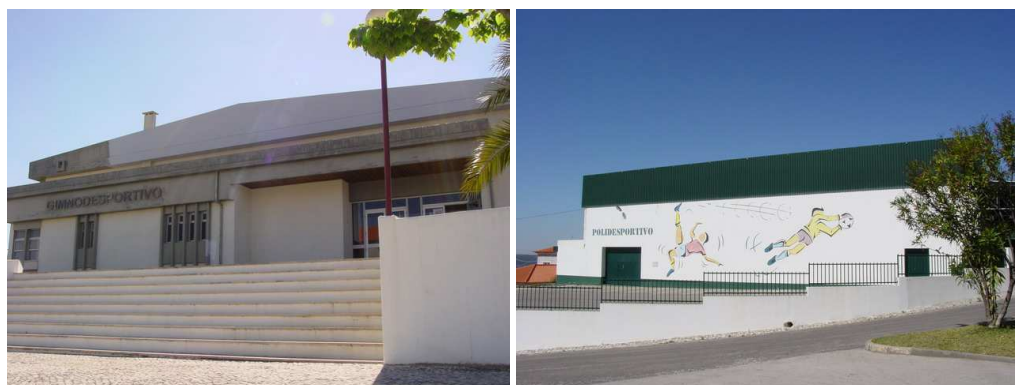
Figura 16. Pavilhão Municipal de Figueiró dos Vinhos | Polidesportivo Coberto da Aguda
