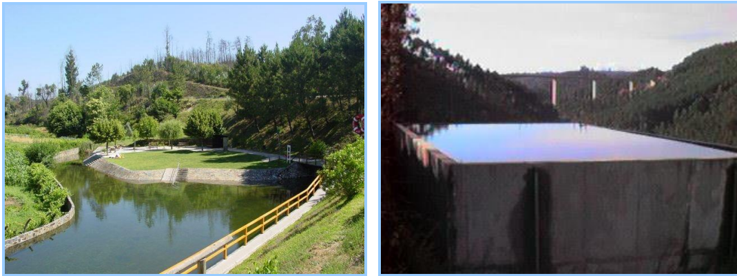
Figura 6 – Beneficiação e construção de pontos de água
